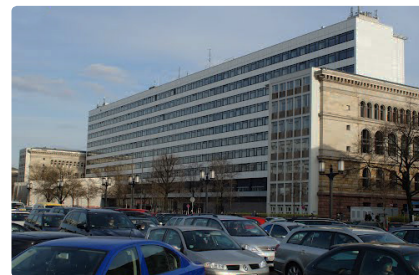
Framhlið háskólans hafði verið sprengd í stríðinu, en nýtt hús byggt í skarðið
